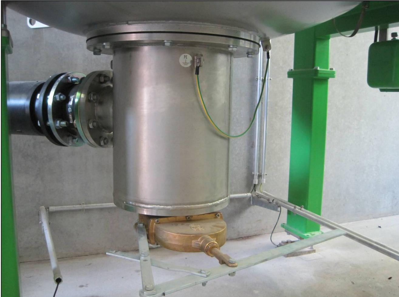
Il resistente dissolver è insensibile all'entrata di materiali estranei. I sassi sono rimossi dal sistema attraverso un blocco dei solidi.
